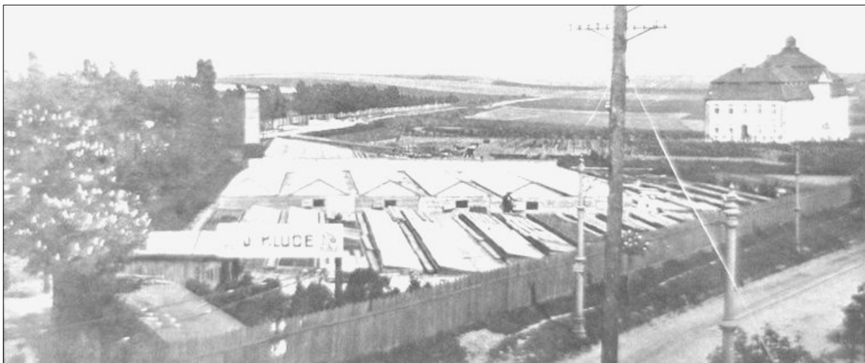
Zahradnictví pana Klugeho bychom našli na místě dnešního hotelu Don Giovanni u stanice metra Želivského. V pozadí budova Hagiboru. Kolem roku 1910. | Foto: Archiv Mgr. Michala Vránského / Městská část Praha 3
